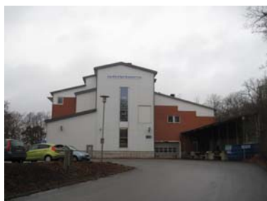
Instalações de impressão da Sydostpressarna
